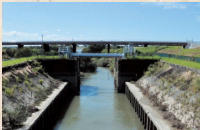
関宿の閘門(利根川と江戸川を船が航行するため昭和2(1927)年に設けられた)
