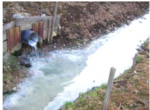
写真；排水路の水質汚濁事故
