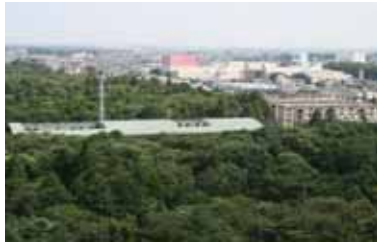
中央の杜(市役所屋上より)
