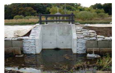
※江川排水路 樋管の写真
