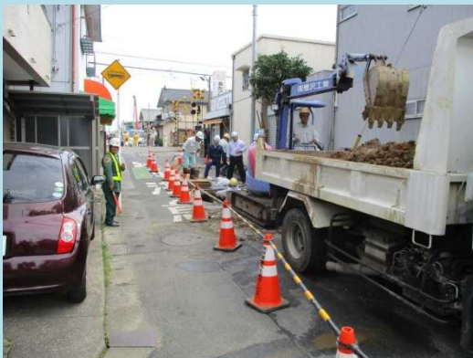
仮線準備工事に伴う支障物移転工事
