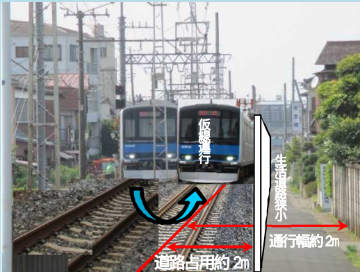
道路幅約 4m の内 約 2m 道路占用
