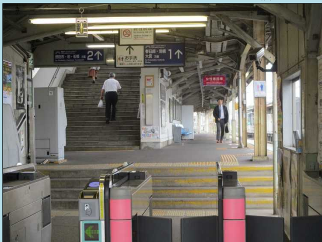
愛宕駅の階段 (エレベータ・エスカレータの未整備)
