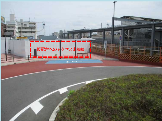
障がい者用停車スペース完成 (仮駅舎と未接続)
