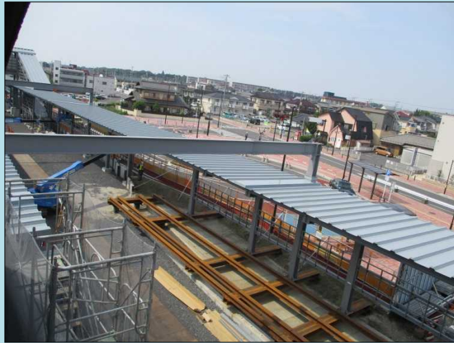
仮ホーム建設
