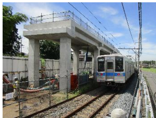
工事が進む鉄道高架事業
