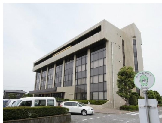
空調設備を改修したいちいのホール
