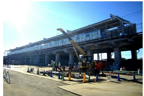
鉄道高架事業（野田市駅東側）
