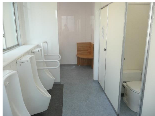
清水台小学校トイレ改修
