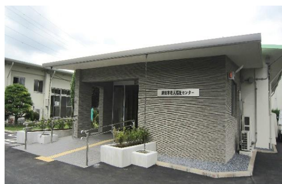
改修が完了した老人福祉センター
