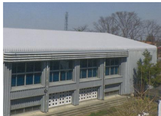
屋根を改修した関宿中央小学校体育館
