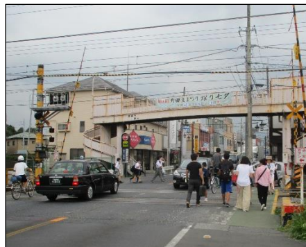
愛宕駅前踏切の歩道狭小 (主要地方道つくば野田線)
