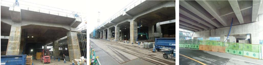
(写真左・中央)野田市駅東側の二期工事高架下を撮影。2面4線+トローリー留置線を予定しているため、高架下は非常に広く、奥行がある。(写真右)橋桁を真下から撮影。橋桁から伸びているホース状の物は仮の雨水排水管。
