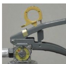
× 安全栓の抜けかけ
