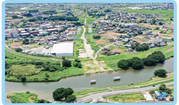
8 松伏町下赤岩地内 (東埼玉道路整備中區間)
