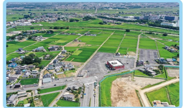
6 松伏町田島地内 (県道中井松伏線交差点付近)
