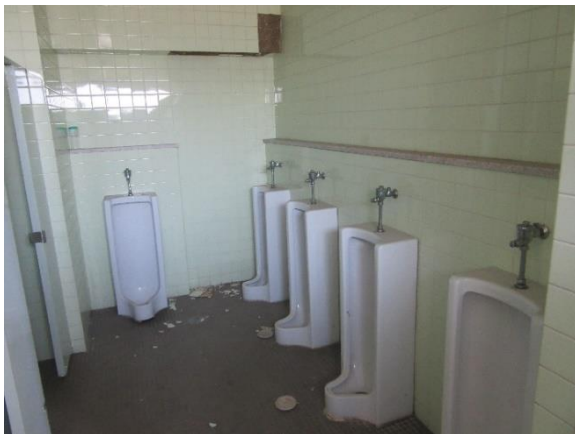
更衣室トイレ
