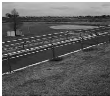
車いす用のスロープも設置
