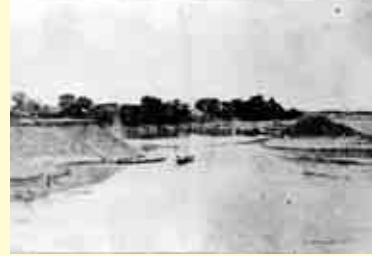
樽を出すには川の水量を調節する関所近くには堤防が築かれています。
