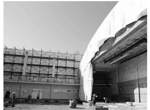
中央小体育館は屋根架け替えに加え耐震補強も実施
