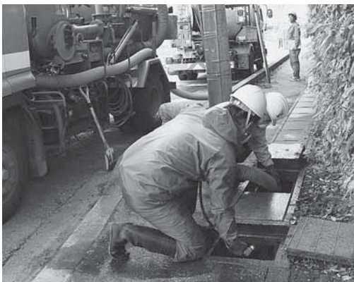
仮置場の設置により道路側溝清掃を再開
