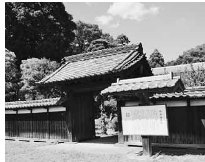
震災被害の修復工事も完了
