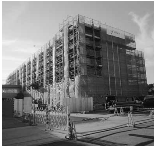
耐震補強工事の進む岩木小学校校舎
