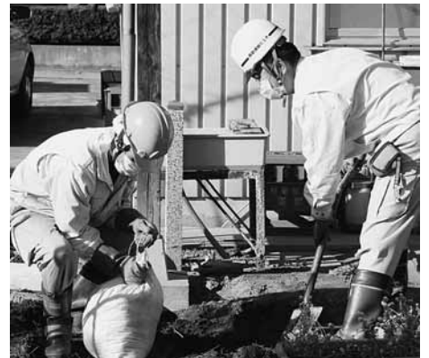
2月28日現在で約94パーセントの除染が完了
