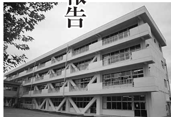
小中学校の耐震補強工事 10棟分などを前倒し
