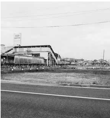
仮線用地の確保を進める愛宕駅周辺
