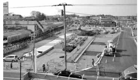
バリアフリー化を含む整備が進む愛宕駅周辺
