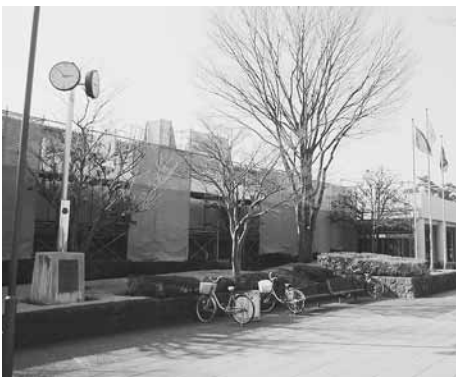
26年度に大体育室の屋根・外壁改修が完成予定
