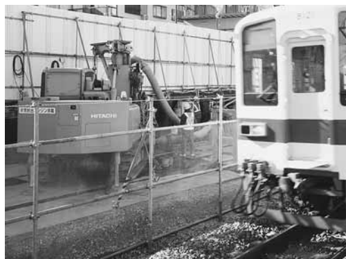
工事の進む野田線(写真は清水公園駅付近)
