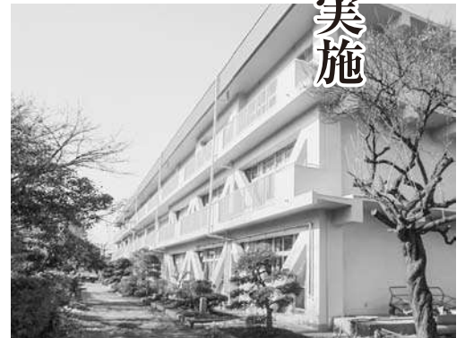
耐震化が完了した第二中学校校舎
