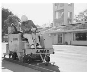
競技場改修工事を施工中。圃社会体育課 ☎712417930
