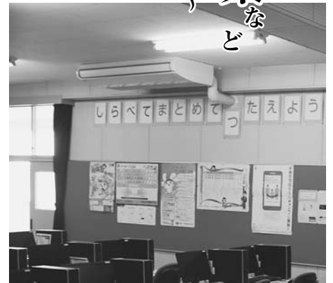
中学校に空調を設置(写真はパソコンルームのもの)
