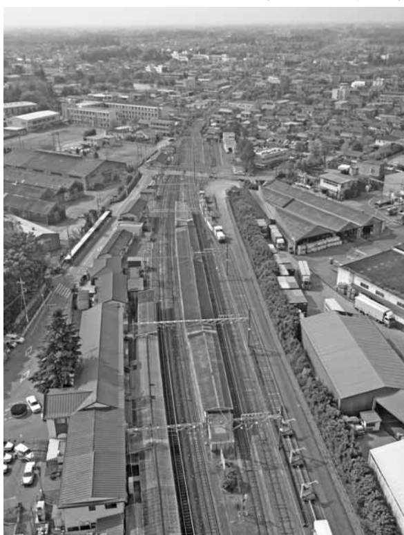
■野田市駅上空から愛宕駅方面（撮影は平成17年）
