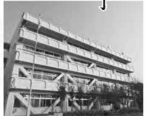
校舎は緊急時には避難所としても利用
