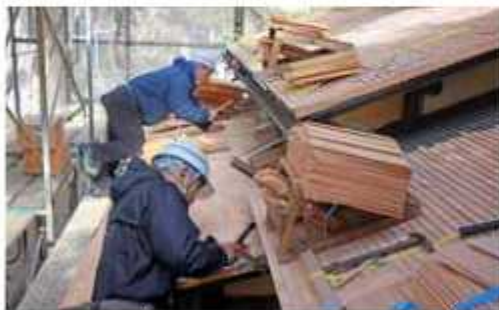
鹿苑寺舍利殿(金閣)の屋根もこけら葺き
