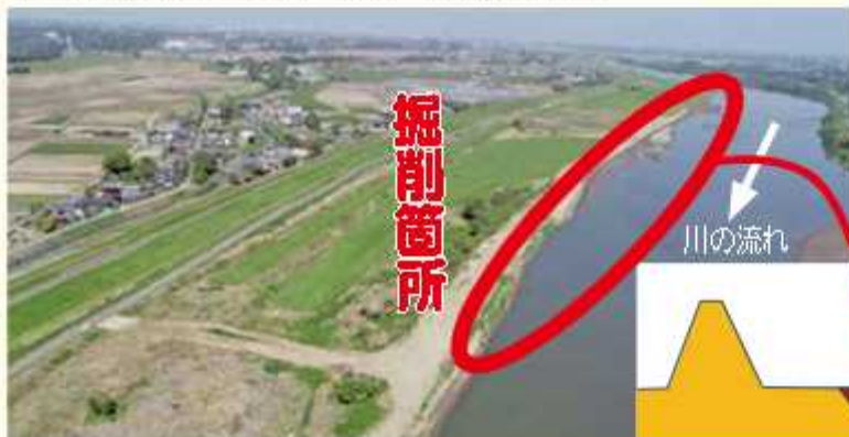
●利根川の小山地先で掘削完了 (令和3年10月)
