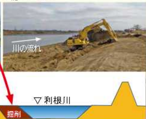
●掘削時の状況
