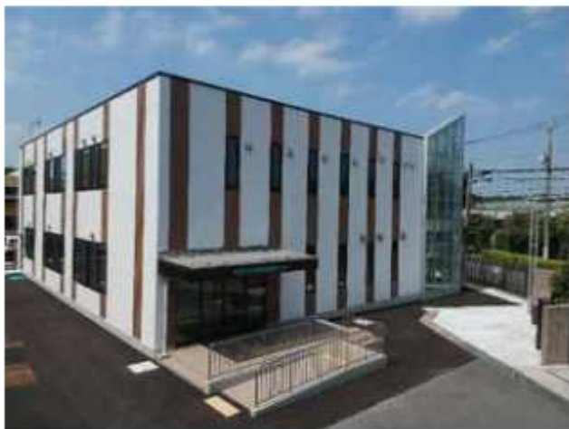
水道部お客様センターは、3月22日頃に水道部敷地内（中根
