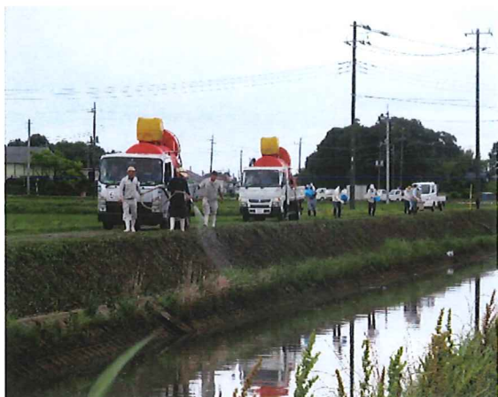
センチピートグラスの水路法面吹付
