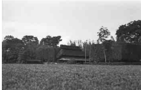
昭和31年に宮本常一が撮影した尾崎の威徳院(上)と茅葺の農家(撮影地不明)／写真提供=周防大島文化交流センター
