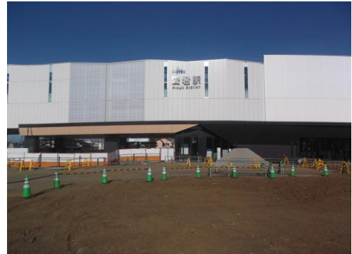
■工事が進む愛宕駅周辺
