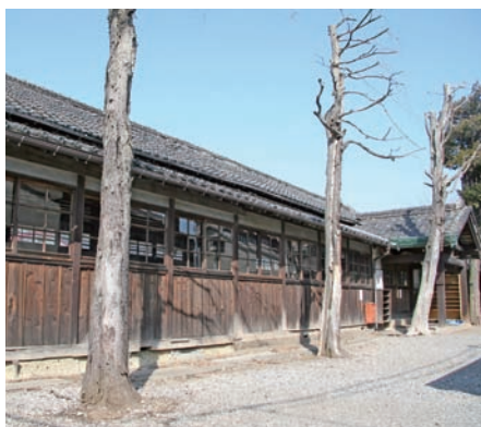
「武道の殿堂」として耐震改修 工事を実施(写真は改修前)
