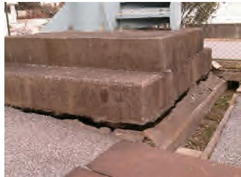
写真；地盤沈下により相対的に
