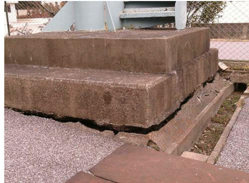
写真；地盤沈下により相対的に
