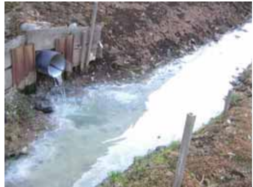
写真；排水路の水質汚濁事故
