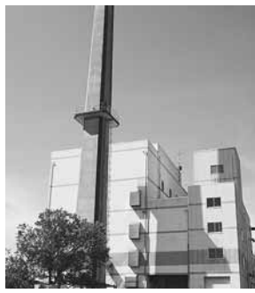
平成26年に稼働停止を予定
