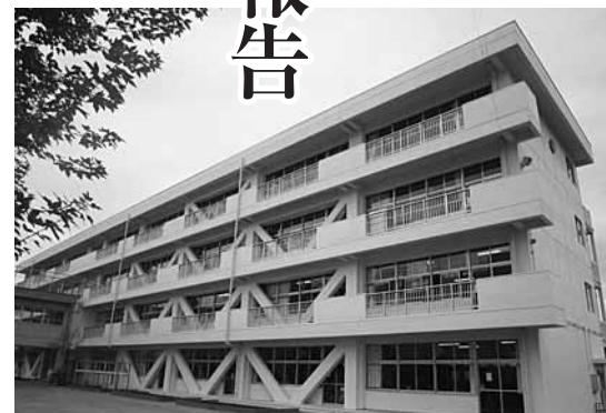
小中学校の耐震補強工事 10棟分などを前倒し
