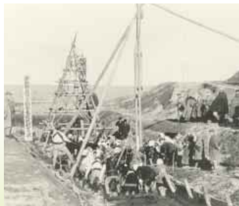
用水機場の建設工事／大正10年ころ・目吹
