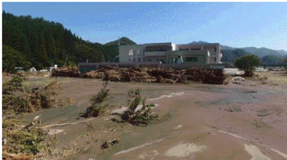
平成28年台風第10号による被害状況
