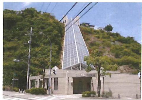
法人で所有・管理する斜行エレベーター [グリーンヒルズ湯の山 (愛媛県松山市)]
