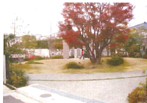
法人で所有・管理する地下式調整池・上部広場 [ブレイズスクエアセンター北 (神奈川県横浜市)]
