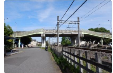
東武鉄道に架かる七光台跨線橋
