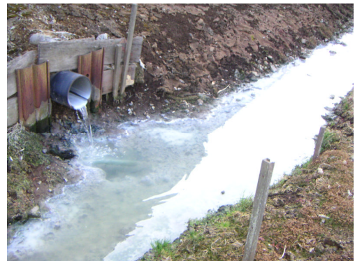
写真；排水路の水質汚濁事故
