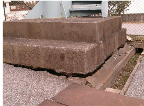
写真；地盤沈下により相対的に
