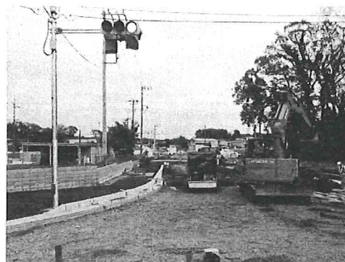
■工事中の外郭環状道路(市道船形吉春線)
