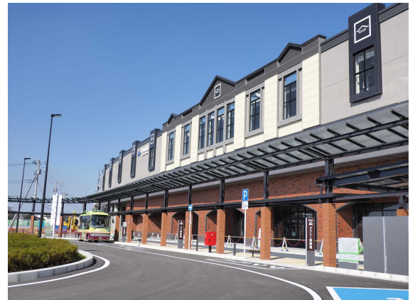
整備された野田市駅前広場
