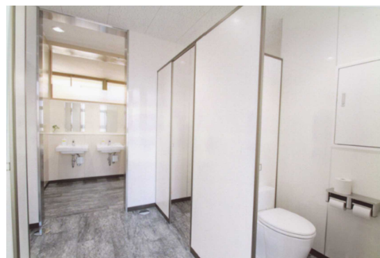
尾崎小学校のトイレ改修
