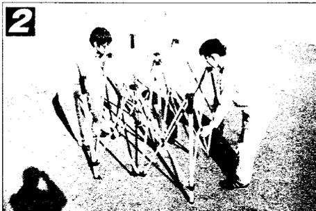
2 トラスバー下側のV字部分を持ち上げながら、外側に引っ張り、本体フレームを半ばまで上げます。
