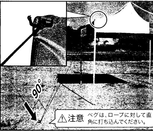
天幕の四隅にあるプラスチックの留め具にしっかりとロープを結び、ベグをテントの対角線上にしっかりと根元まで打ち込みます。
