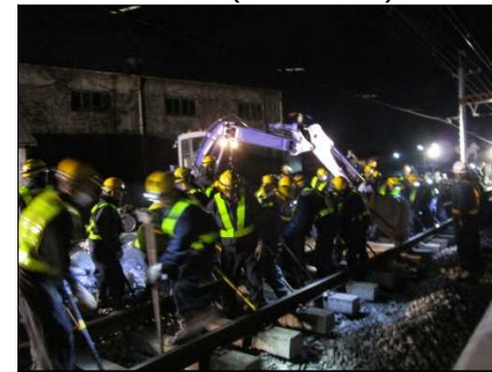
仮線切替え(夜間工事)
