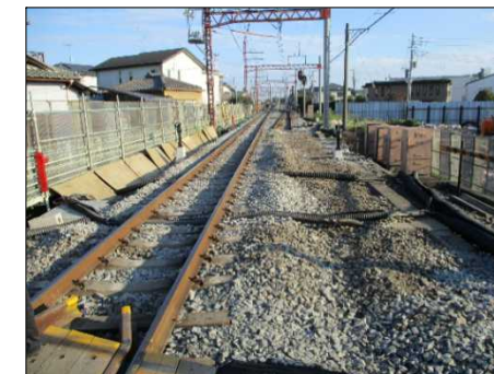
野田市駅北側仮線切替え
