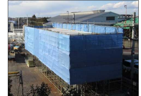
野田市駅南側高架橋本体工事
