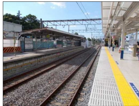
高架橋本体工事
