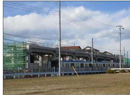
愛宕駅北側仮線切替え
