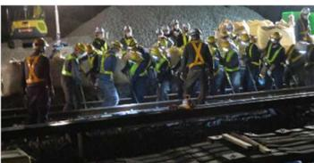
3月28日列車運行前に、線路切替工事を実施しました。大勢の作業員が掛け声に合わせて一言で、終電から始発までの短時間にて作業を完了させる作業員の皆様の気迫と熱意を感じることができました。
