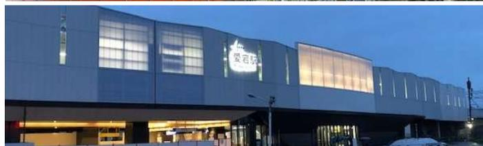
駅舎の正面中央部には船の帆をイメージした光触媒塗装のガラス繊維織物を用いております。照明の透過光により帆が浮かび上がり、幻想的な雰囲気になります。
